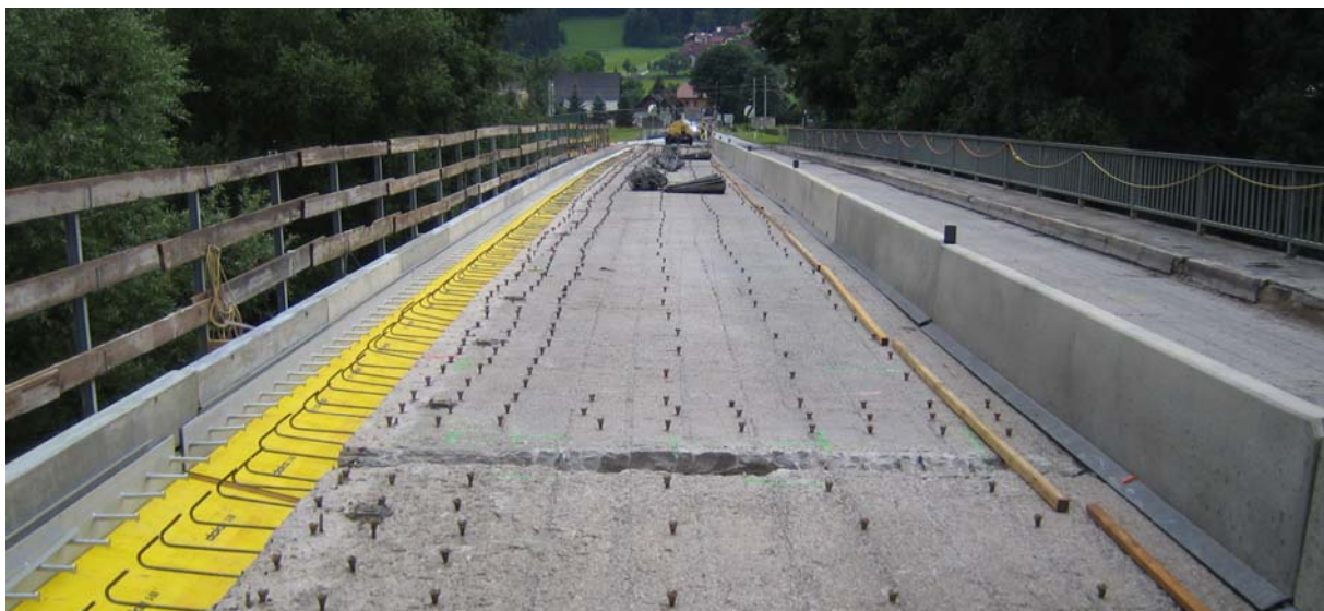
Bauphase 1 – Verdübelte Fahrbahn mit neuem Kragarm
