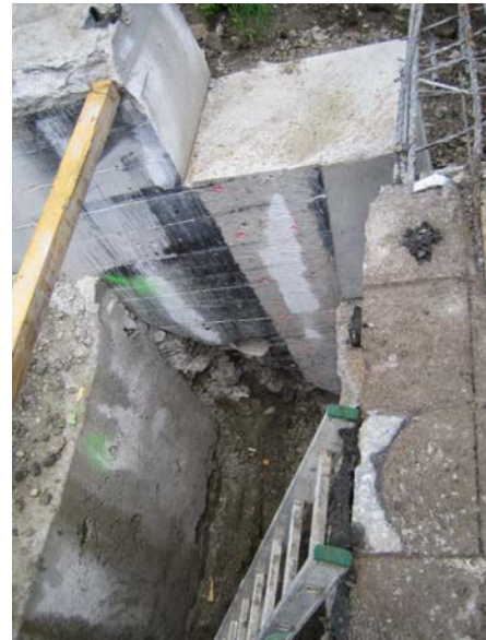
Freigelegte Flügelwand mit Abbruch
